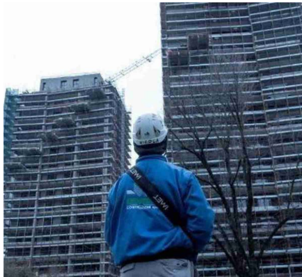
Cantiere per la realizzazione delle nuove torri in zona Crescenzago
